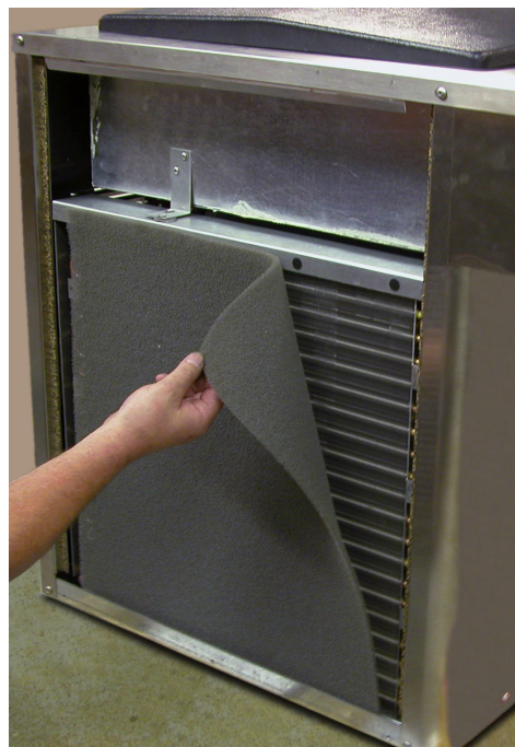
Figure 3-11 F112 Enlèvement du Filtre du Condenseur
